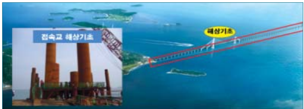
그림 5 수중불분리 콘크리트 적용 구간
