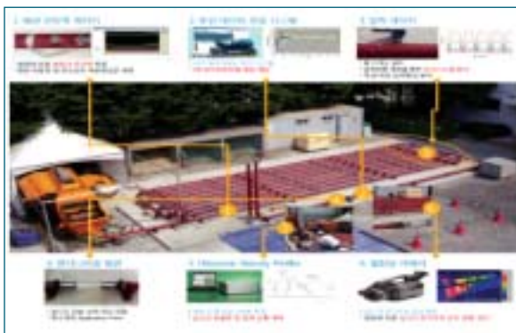
그림 1 Semi-scale test 전경 및 계측 상세
